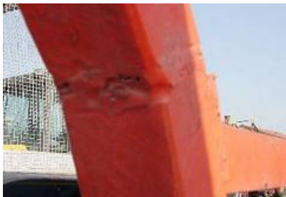
Fig. 8. Esempio di ammaccatura di tubolare a sezione non circolare con depressioni della superficie che interessano anche gli spigoli e assottigliamento della sezione resistente utile
